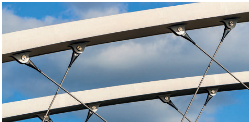
Eine Innovation sind die geeigneten, sich kreuzenden Hängerseile aus Carbon-Zugelernen (Bild: sbp-Andreas Schnubel)
