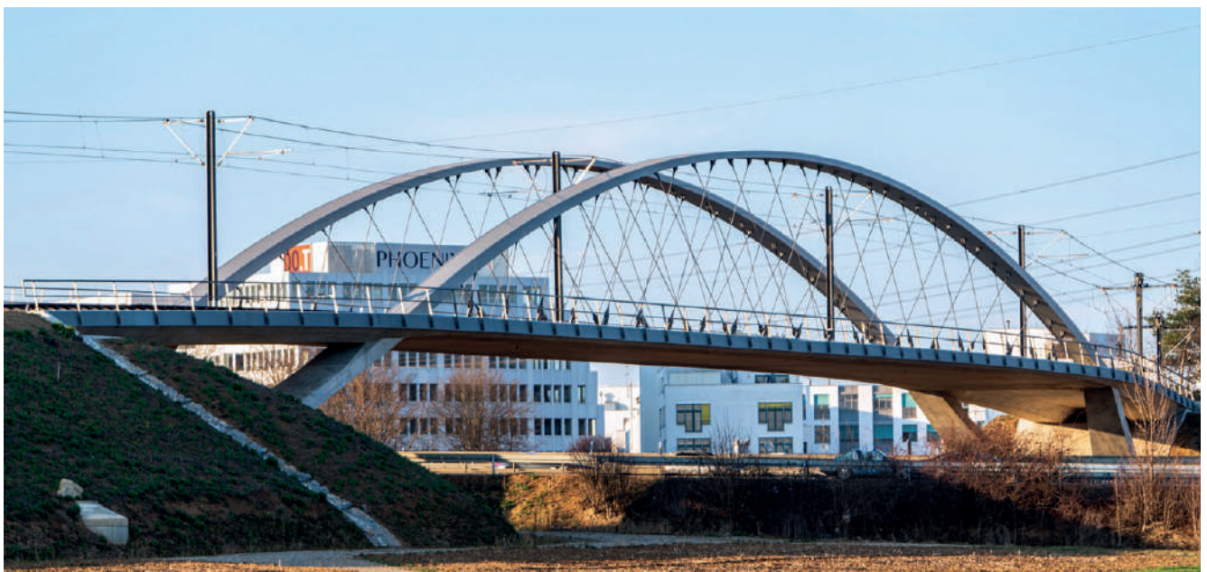
Achtzig Meter weit überspannt die Stadtbahnbrücke die A8 an der Anschlussstelle Stuttgart-Degerloch (Bild: sbp-Andreas Schnubel)
