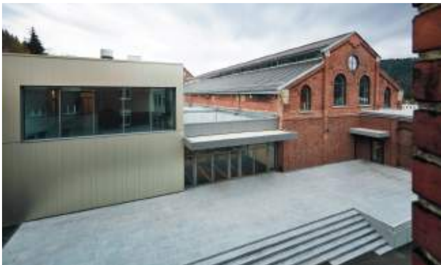
Das denkmalgeschützte Schmiedegebäude von Aesculap mit dem neuen Anbau (Quelle: Sinfiro)
